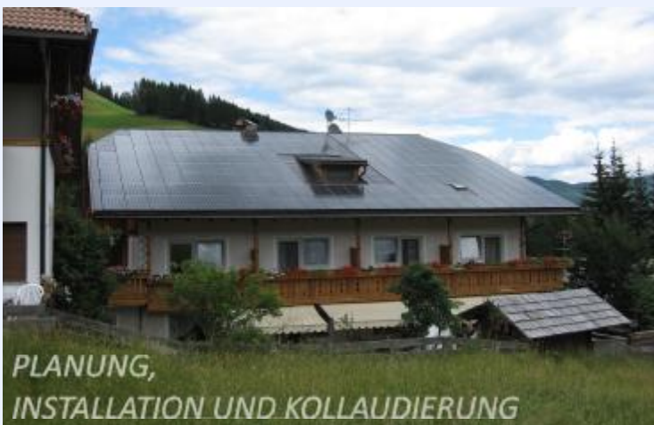
Aufdachanlage mit 33,825 kWp.
